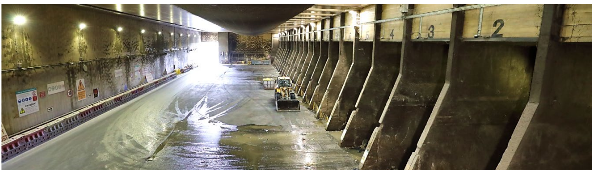
Warten auf die Müllabfuhr - Müllverbrennungsanlage der LondonEnergy Ltd, Foto S. Knoll
