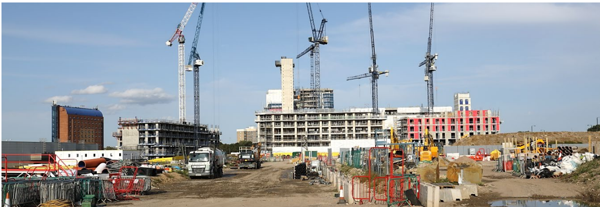
Die Baustelle des Stadtquartiers "Projekt Brent Cross Town", Foto S. Knoll
