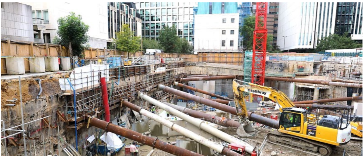
Aktueller Baustellenfortschritt 2 Aldermanbury Square, Foto: S. Knoll
