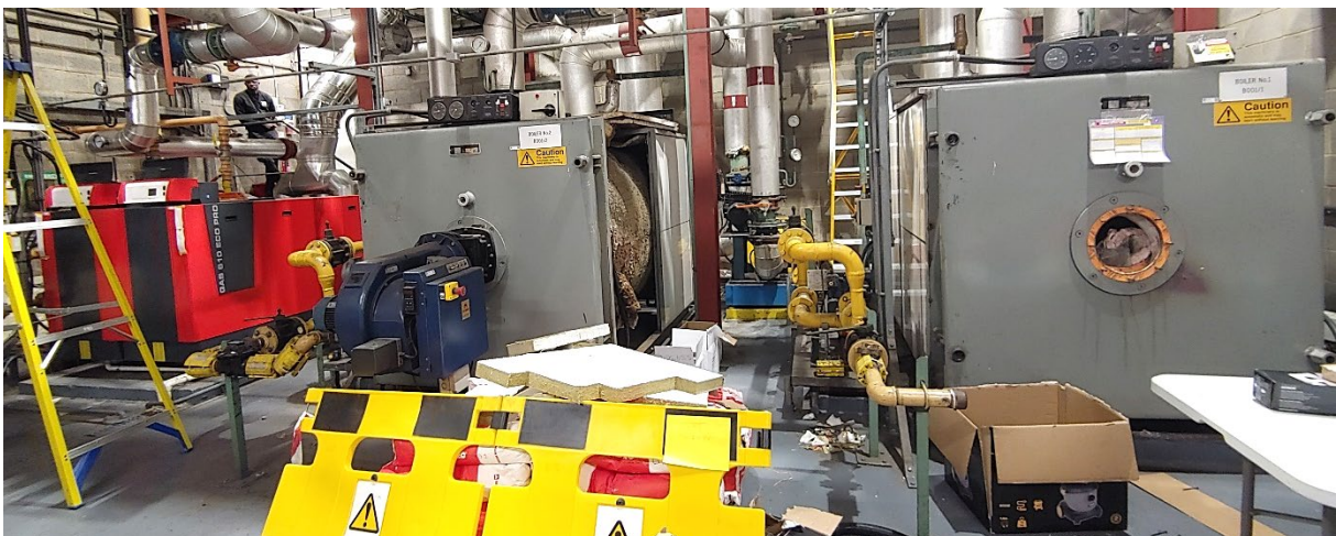
Vorbereitungen Austausch der Boiler in 200 Gray's Inn Road, Foto: O. Kühner
