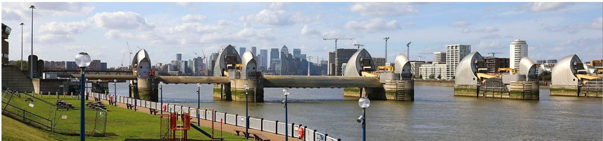
Sturmflutsperrwerk Thames Barrier - Die linken Sperrtore befinden sich in Revision, Foto: S. Knoll
